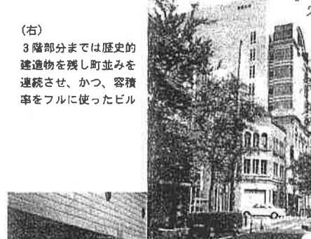
(右) 3階部分までは歴史的建造物を残し町並みを連続させ、かつ、容積率をフルに使ったビル
